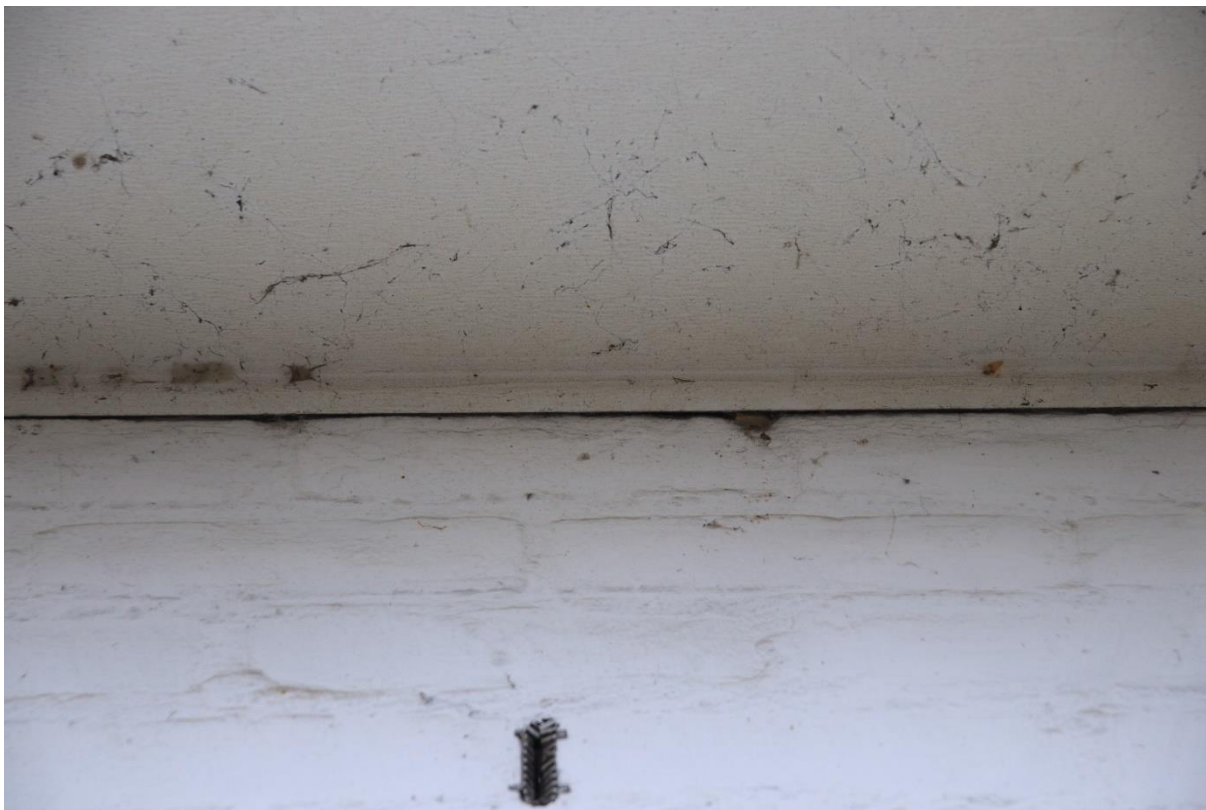
Foto 3: In alle open stootvoegen zijn bijenroosters aanwezig. De spouw is dan ook niet toegankelijk voor vleermuizen
